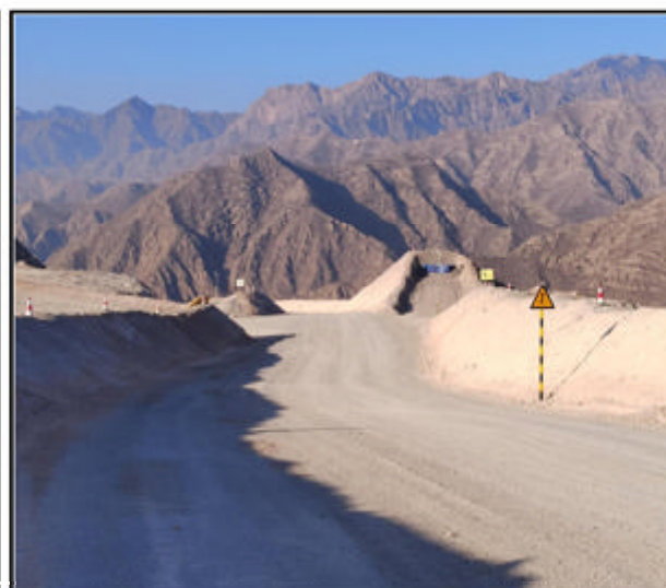
应急避险车道
