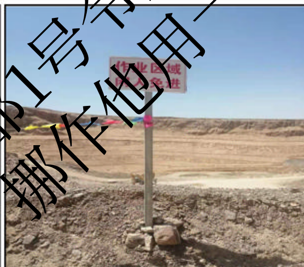
采区运输道路挡车墙及警示标志
