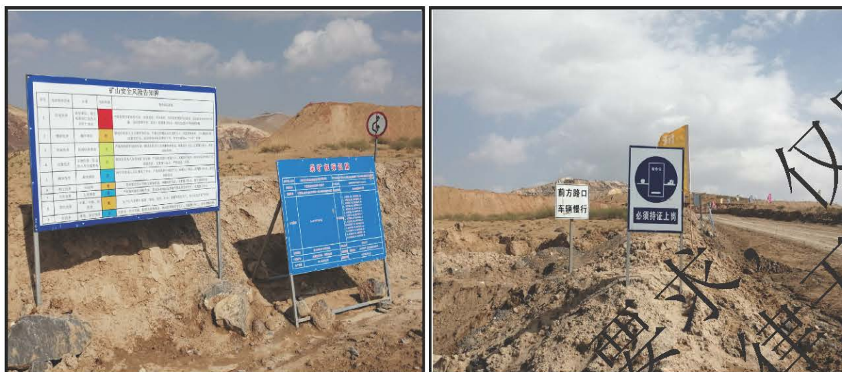
矿山现场安全风险告知牌及警示标牌
