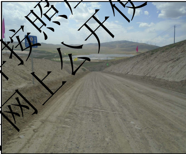
运输道路、安全警示标志及挡车墙
