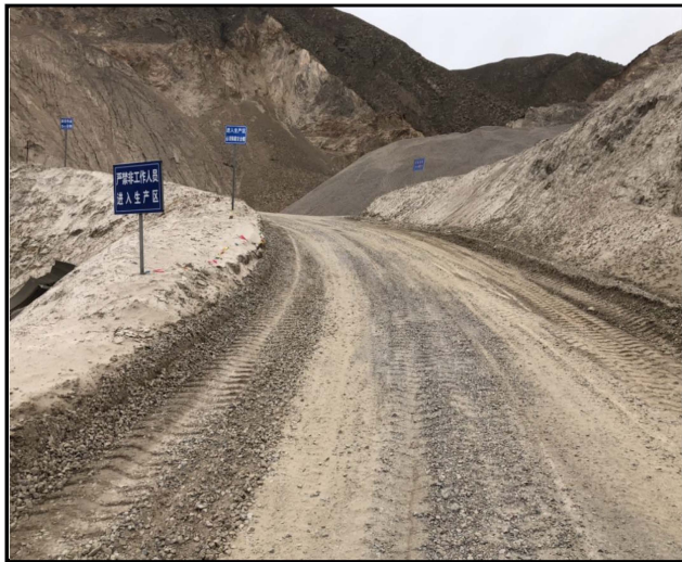
运输道路、安全警示标志及挡车墙
