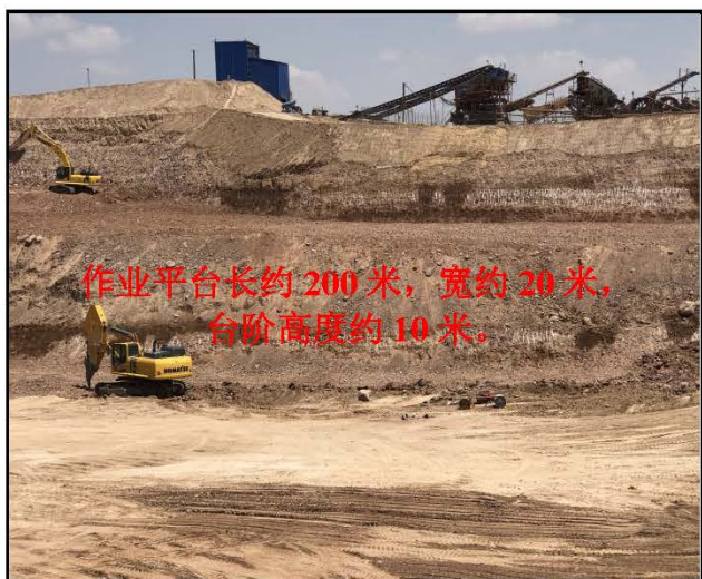
矿山采面近景
