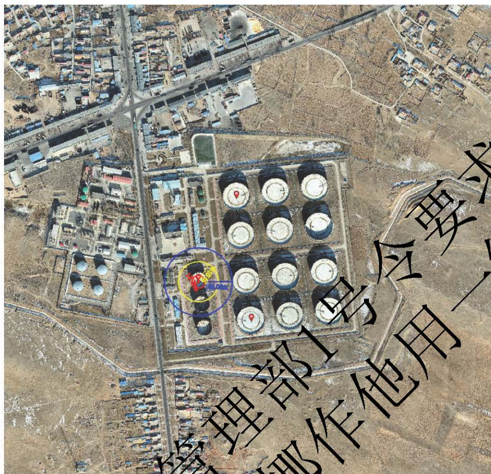
图 6.3-6 1#原油储罐外部安全防护距离
