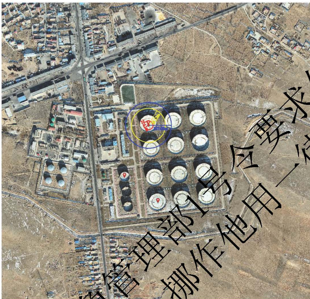
图 6.3-4 01#原油储罐外部安全防护距离
