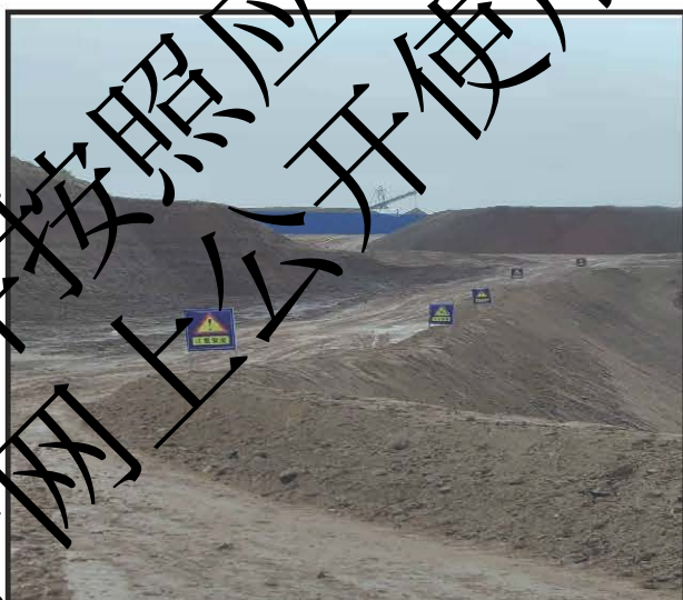
运输道路及挡车墙、安全标识
