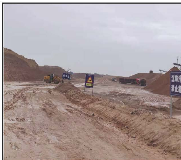
运输道路及挡车墙、安全标识
